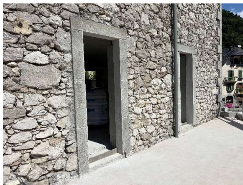
Création d'ouvertures terminées
