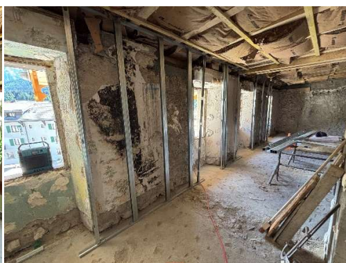
Travaux de doublage du R+1 en cours
